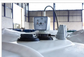
3. Système anti-débordement avec sonde
