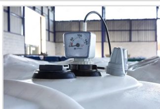
3. Système anti-débordement avec sonde
