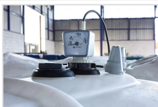
3. Système anti-débordement avec sonde
